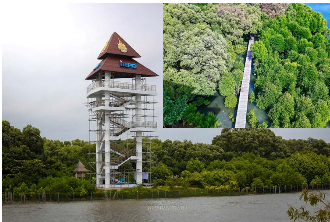
รูปภาพที่ ๑๓ หอชมวิวเฉลิมพระเกียรติ ศูนย์การเรียนรู้ระบบนิเวศป่าชายเลนพระเจดีย์กลางน้ำ
